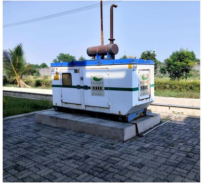
DG Set Area
